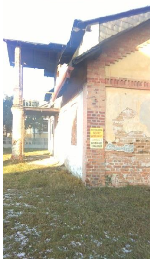
Zdjęcie 3. Budynek przy ul Rumuńskiej 2
